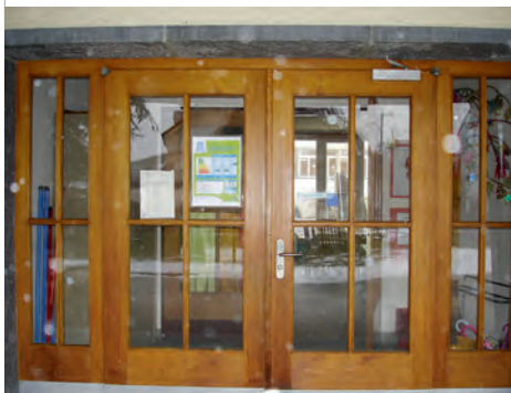
Etiquette énergie au collège de Fontenay (Yverdon-les-Bains)
